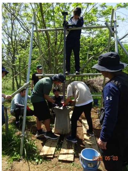
繋いでいたロープを引き、継手パイプを取り出す
