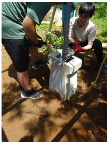
小石を入れ継手パイプ、手漕ぎポンプを設置
