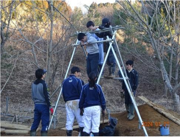
5 m掘り進み、本日の作業終了
