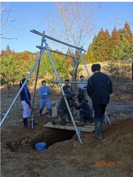
穴掘り器で掘ってロープで引き上げる
