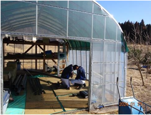
1本目の塩ビ管にドリルで穴をあける。
