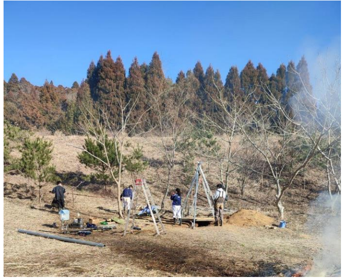
単管パイプで櫓を組む
