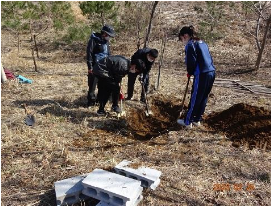
井戸掘り作業 穴掘り作業開始
