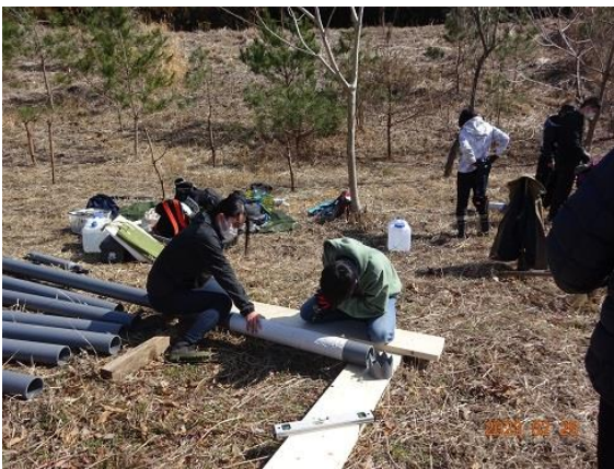
4mの井戸枠下側のドリルでの穴あけ作業
