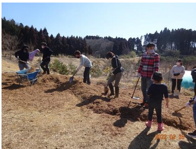
もうすぐチップ舗装完成です。
