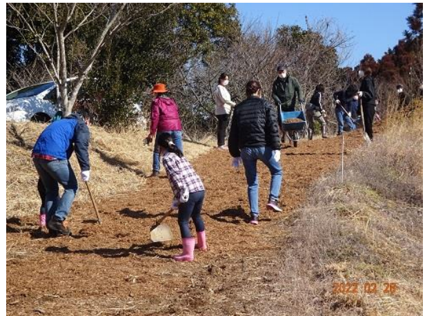
チップ舗装作業
