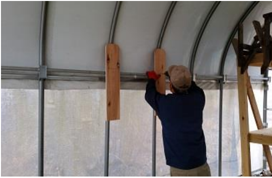
サンクスボードの土台設置
