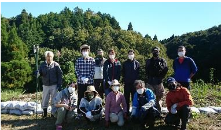
土嚢積み無事終了
