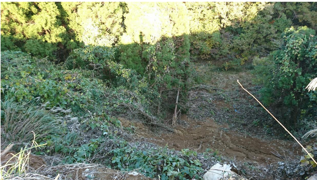
台風 21 号による大きながけ崩れ
