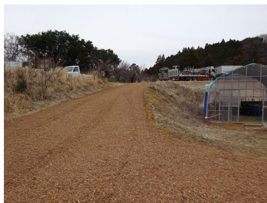
その上に細かいチップを敷きローラーで転圧して完成しました。木の香りが良い！
