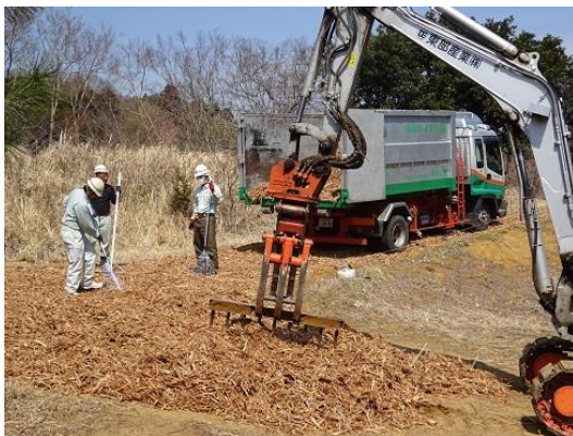
水はけを良くするため、粗いチップを下にしてローラーで転圧
