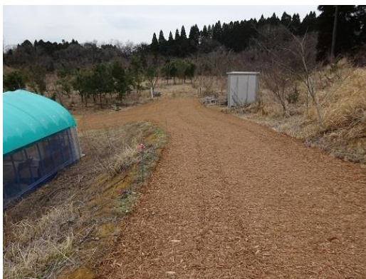
その上に細かいチップを敷きローラーで転圧して完成しました。木の香りが良い！
