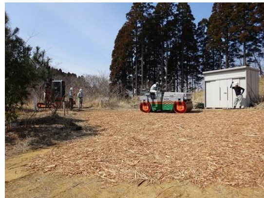
水はけを良くするため、粗いチップを下にしてローラーで転圧
