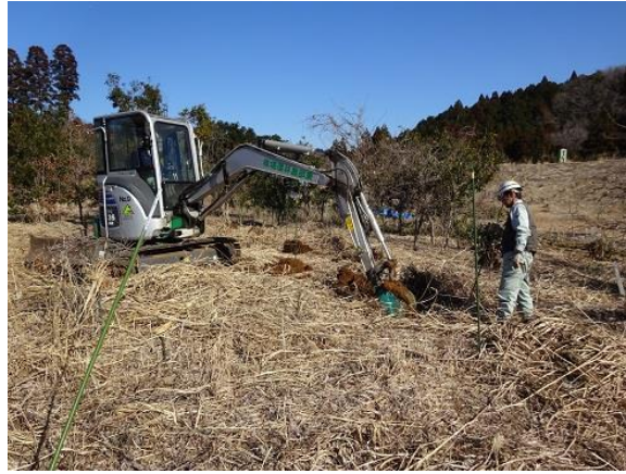
1/26 専門家によるバックホウで穴掘り
