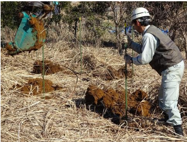
支柱を立てた 120 か所の穴掘り
