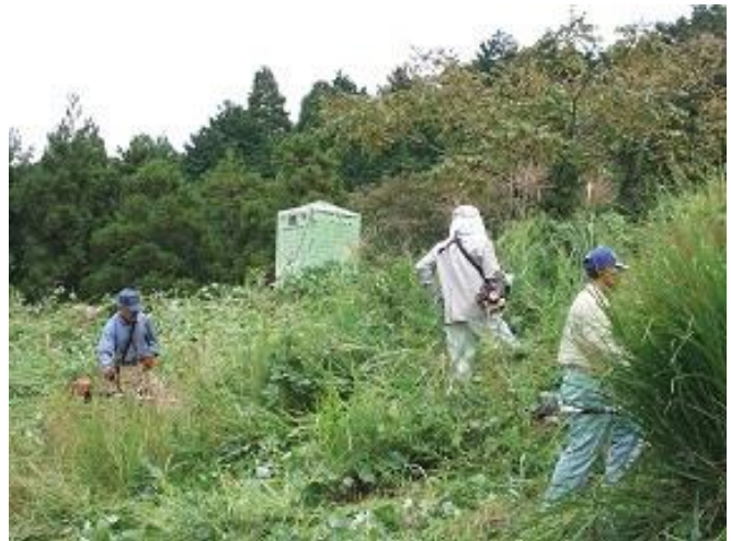
斜面の除草作業
