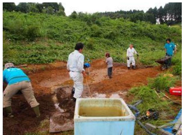
人手のいる作業で泥の重いこと
