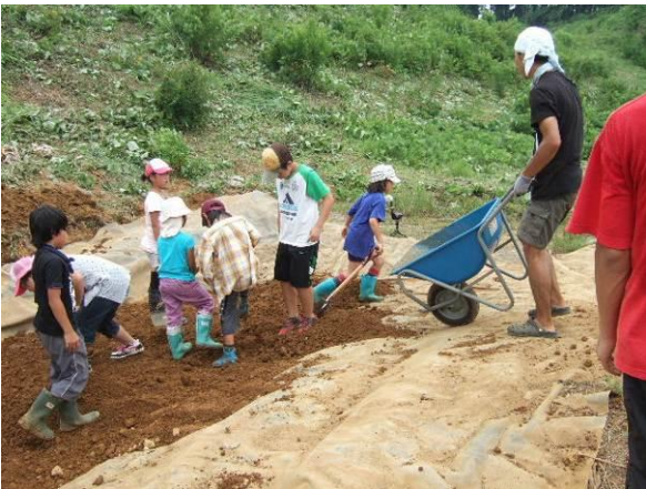
赤土粘土を大人が運び、子ども達が踏み固める
