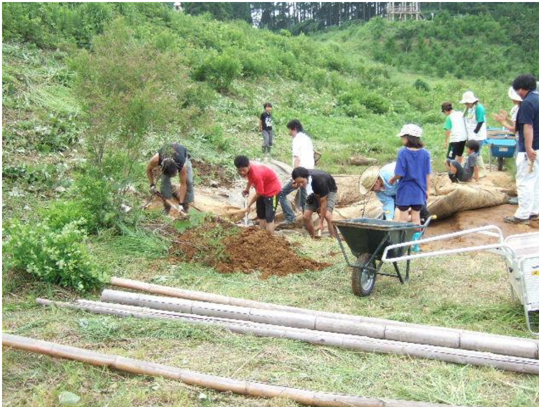
ポンドシートと不織布をめくって、池の縁を揃える作業
