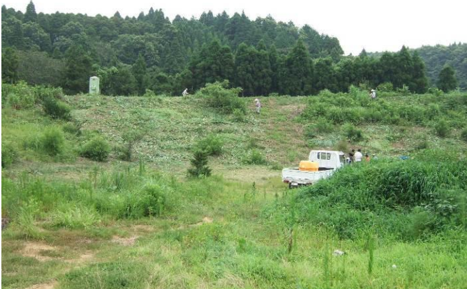
東側斜面の除草作業
