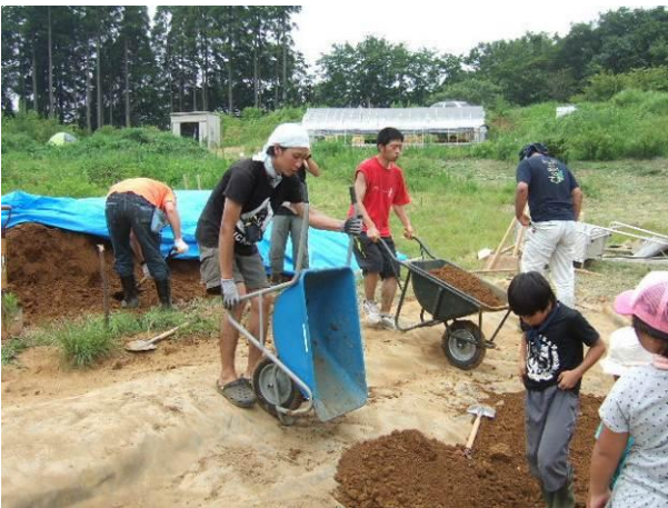
赤土粘土を大人が運び、子ども達が踏み固める
