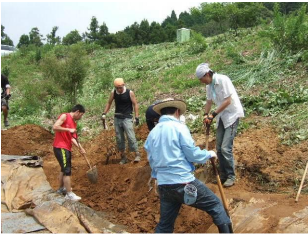
ポンドシートをはがし、池の縁の高さを調整
