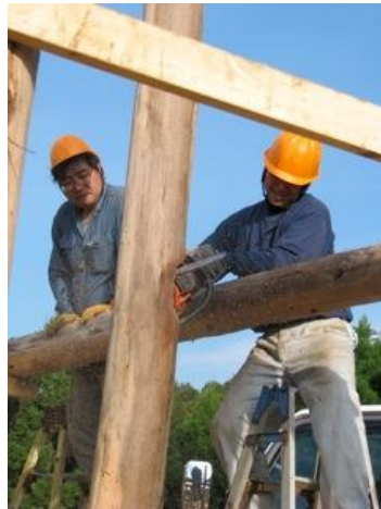
柱9本と梁3本をボルトにて固定するためにチェーンソーにて削る。これが難作業でした。
