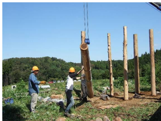
事前に皮むきしていた柱をクレーンで吊り上げツリーハウス作り開始
