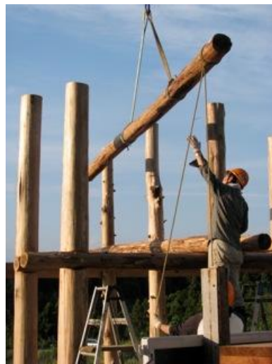
クレーンにて根太6本を敷設し、銼にて固定。
