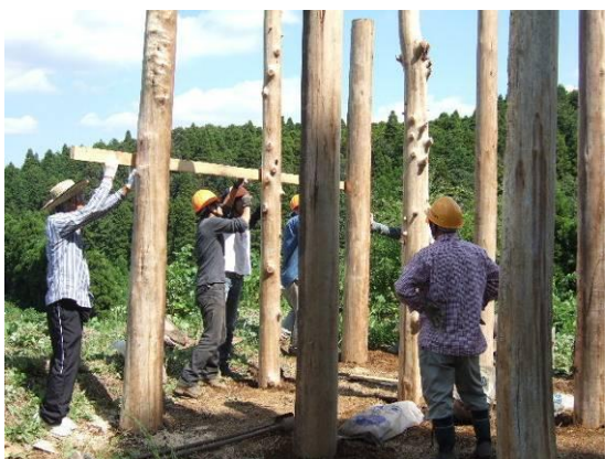
梁を支える仮板を敷設し、作業をしやすくする。
