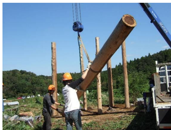
事前に皮むきしていた柱をクレーンで吊り上げツリーハウス作り開始
