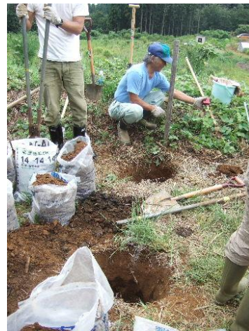
大川さん、猪野さんの応援を得て、手分けして、柱9本用の穴(深さ90cm)を掘る。
