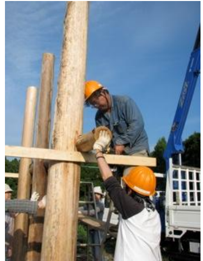
柱9本と梁3本をボルトにて固定するためにチェーンソーにて削る。これが難作業でした。
