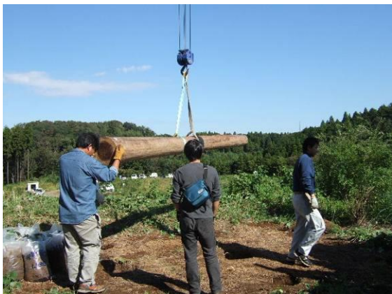
事前に皮むきしていた柱をクレーンで吊り上げツリーハウス作り開始
