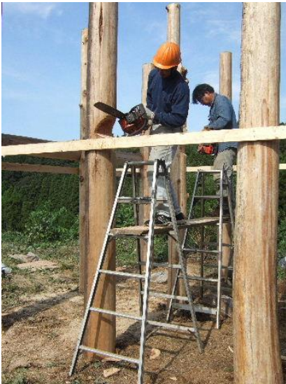
柱9本と梁3本をボルトにて固定するためにチェーンソーにて削る。これが難作業でした。
