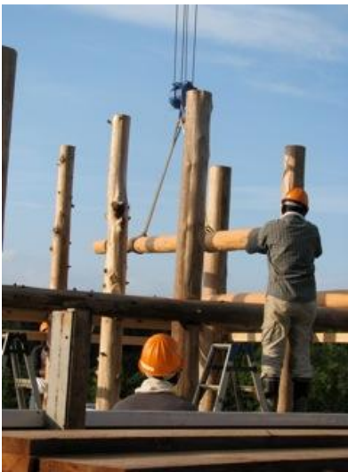
クレーンにて根太6本を敷設し、銼にて固定。
