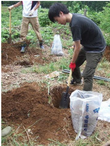
大川さん、猪野さんの応援を得て、手分けして、柱9本用の穴(深さ90cm)を掘る。
