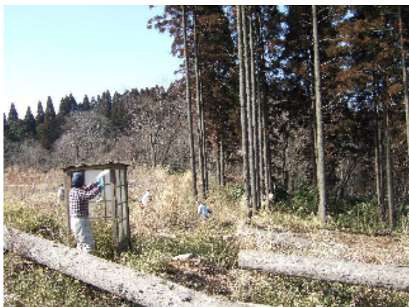
トイレの解体
