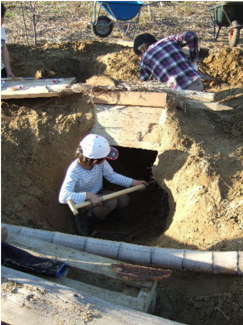
トンネル工事？
