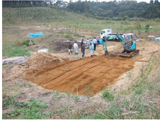
重機も威力を発揮
