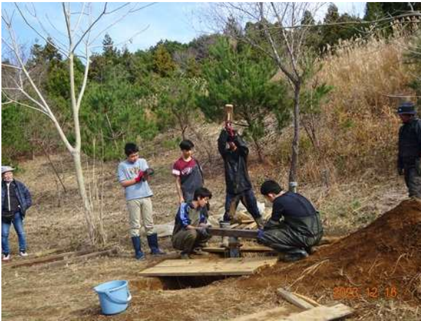
8mまで塩ビ管を打ち込む
