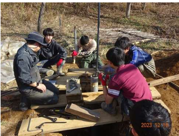
作業棒に穴をあけ鉄棒を差し込み、引き上げようにも全く動かず。
